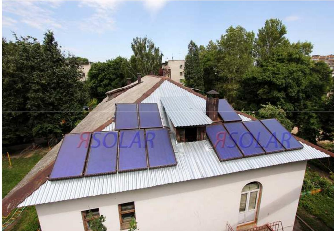
С ноября 2013 года во Владимирской области функционирует солнечная водонагревательная система на базе солнечных коллекторов Яsolar. Суммарная площадь коллекторов 22 м<sup>2</sup>. Показания полученной тепловой энергии данной системой постоянно фиксируются и анализируются специалистами нашей компании.
