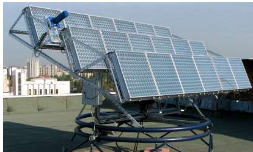
Солнечная энергоустановка на основе 2592 линз Френеля и каскадных солнечных элементов
