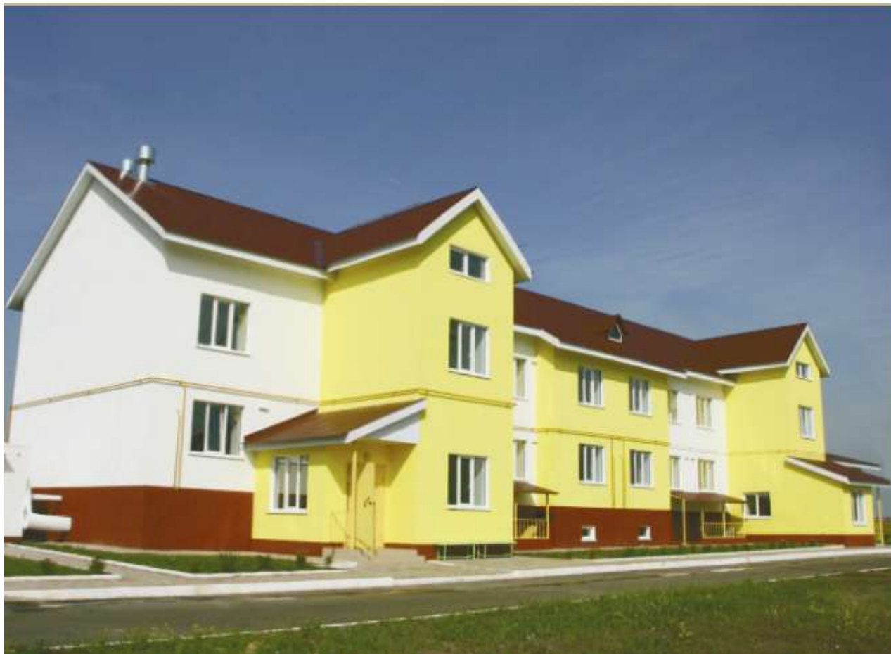
Рисунок 1. Многоквартирный жилой дом с энергообеспечением от ВИЭ
